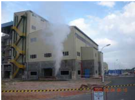
图 #2 炉吹管工作现场
