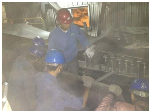
输煤皮带接头连夜硫化
