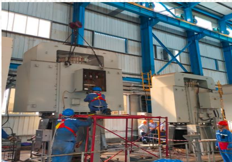
循环水泵检修解体
