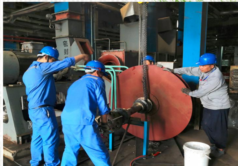
密封风机设备安装
