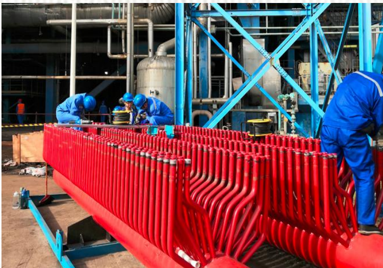
锅炉低再集箱打磨
