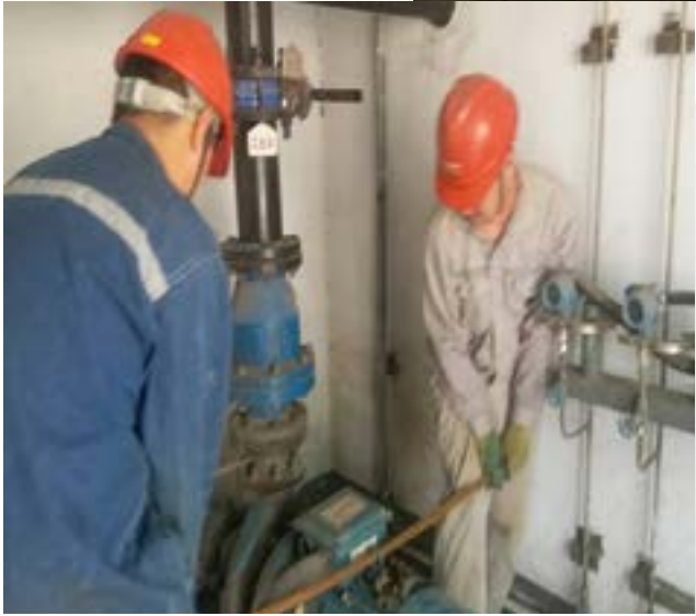
工业水泵检修工作进行
